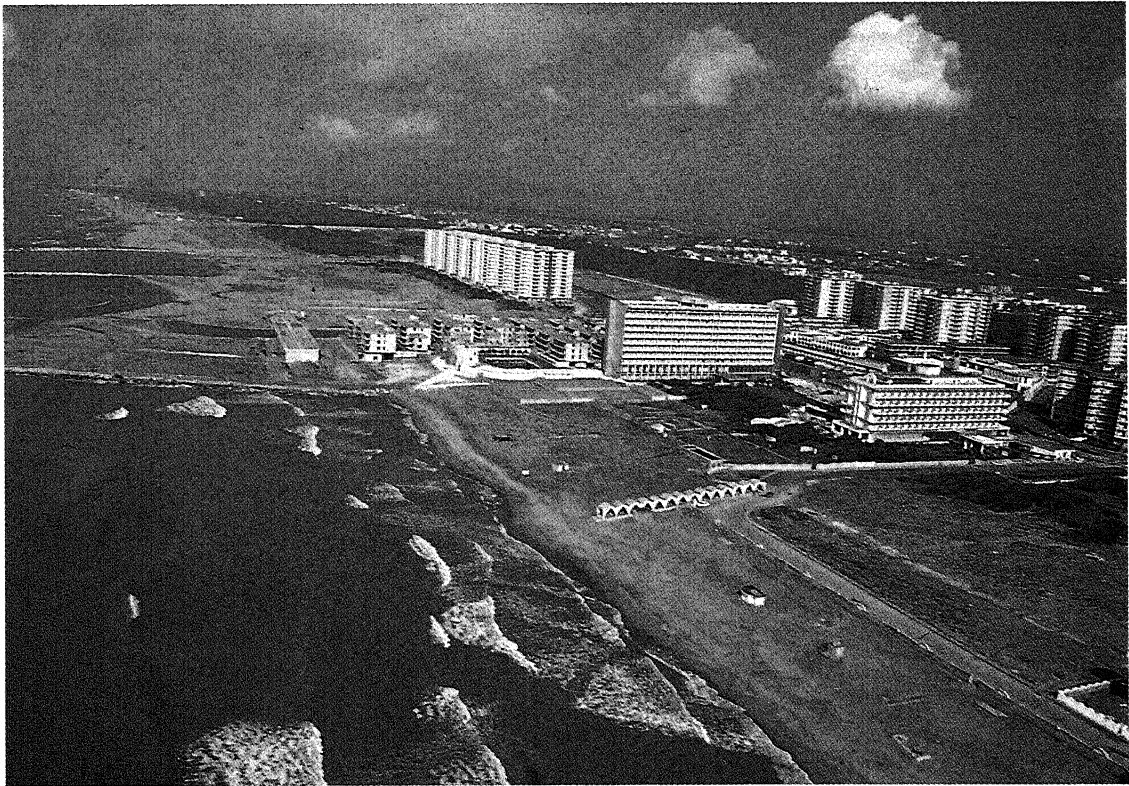
Fig. 4 - Notevole arretramento della spiaggia nell'area di sottoflutto in conseguenza della realizzazione dei moli del Porticciolo di Pineta Mare. Remarkable beach retreat on the downdrift side following the construction of the Pineta Mare marina.
