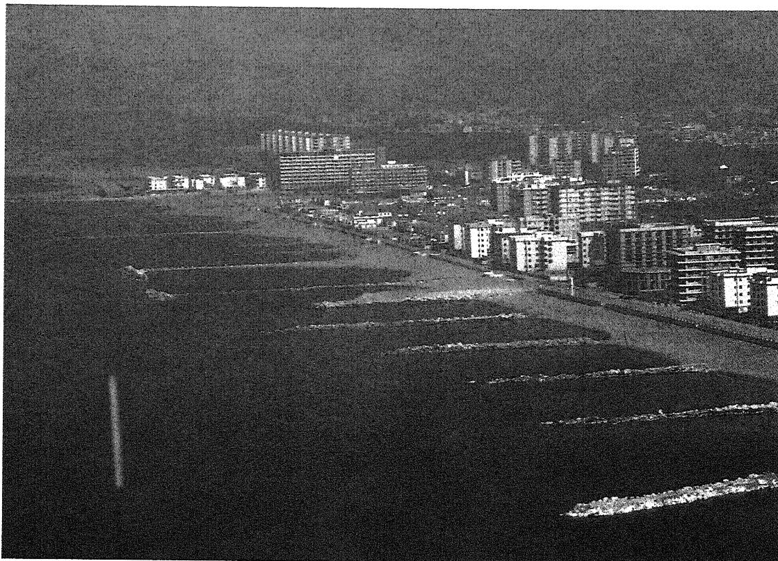
Fig. 5 - Opere di difesa (14 pennelli trasversali — di cui 4 a T) nell'area di sottoflutto del Porticciolo di Pineta Mare. Protective structures on the downdrift side of the Pineta Mare marina (14 groins, four of which with parallel spur).
