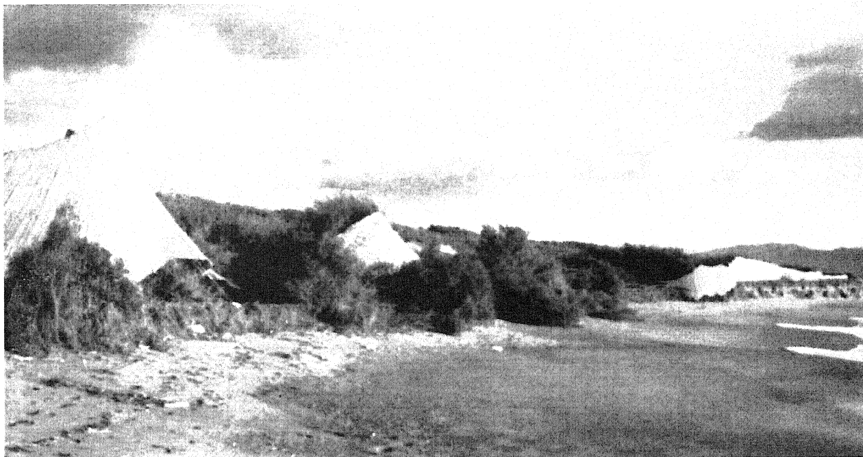
Fig. 8 - Tratto tra Lido Corsaro e Pontile in corrispondenza del c.s. n. 48 (vedi Fig. 3). La mareggiata del novembre '96 ha eroso completamente la duna "mobile", abbattendo la recinzione e distruggendo la retrostante paleoduna fissata dalla pineta.
