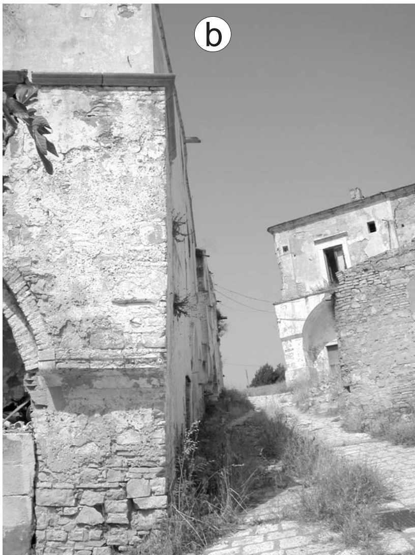
Fig. 8 – a) veduta di Craco; b) casa inclinata lungo il fianco sinistro della frana del centro storico.
