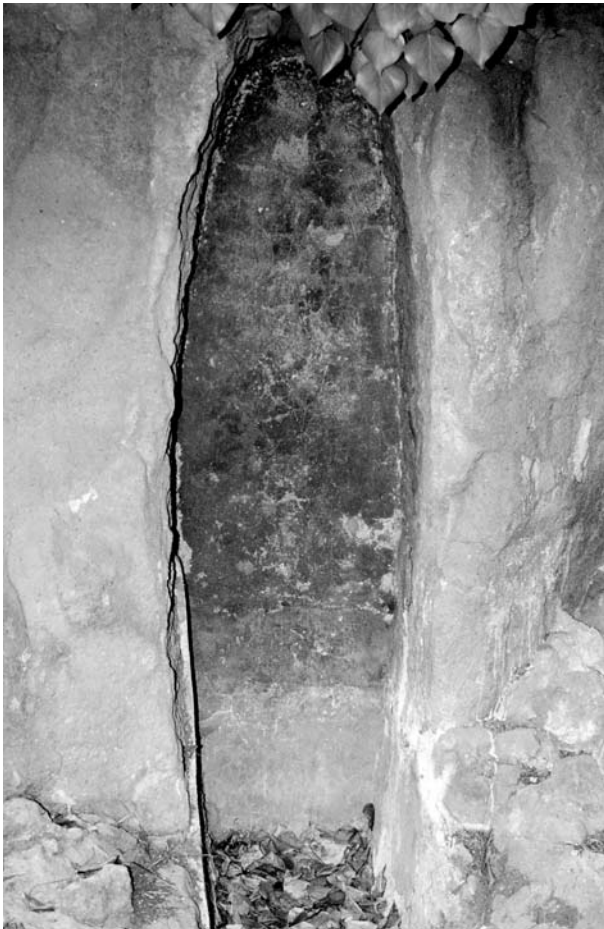
Fig. 28 - Cunicolo rivestito in cocciopesto lungo la Via di Monte Tarpeo.
