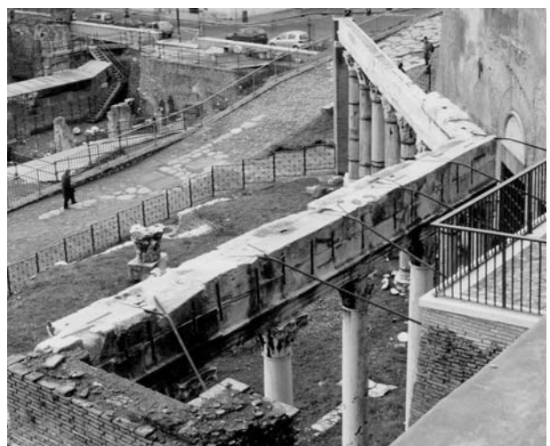
Fig. 22 - Portico degli Dei Consenti. La forma del portico fa presupporre l'addossamento della struttura a un pendio modificato e regolarizzato dall'attività di cava.
