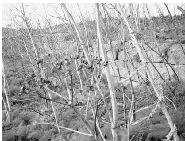
Fig. 12 - Lunghe tratte della cinta muraria di Tarquinia vecchia, interessate dal movimento del terreno fondale, hanno perduto la verticalità e sono prossime al ribaltamento.
