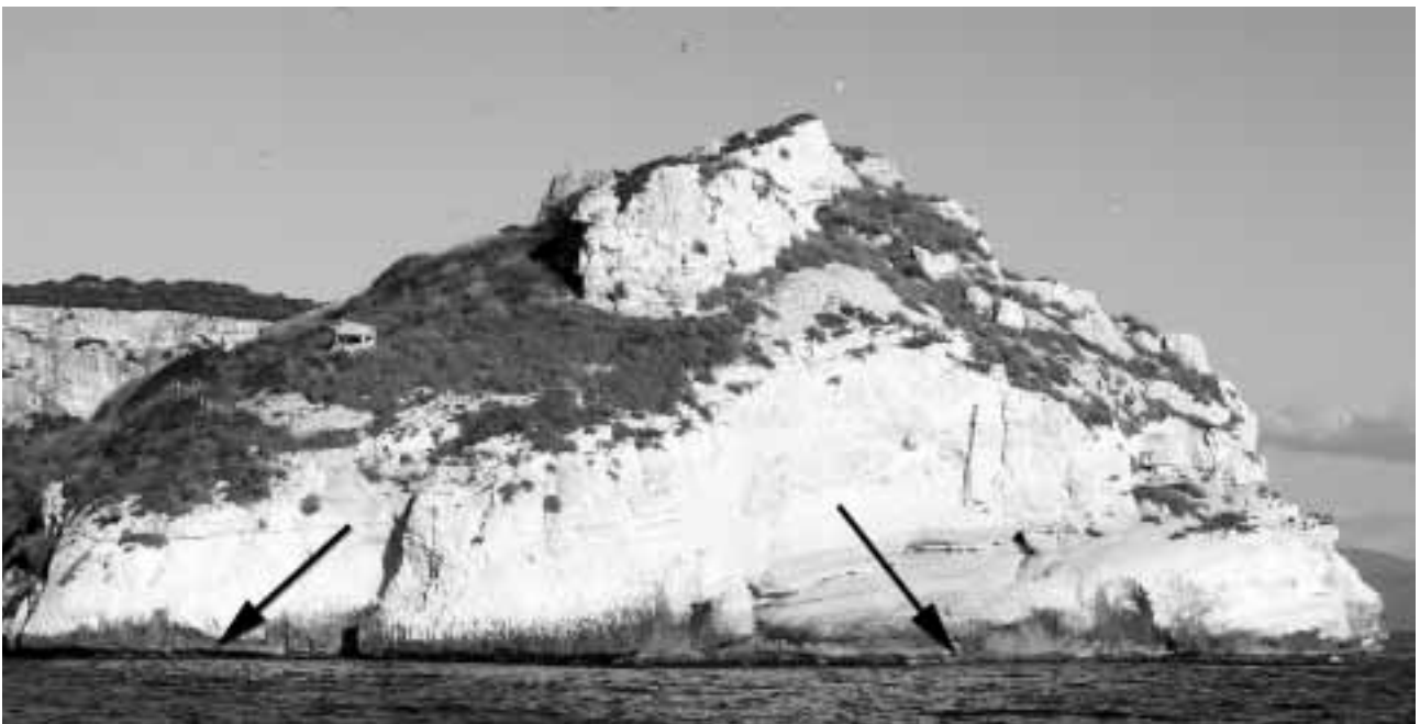
Fig. 4 - Il solco di battente attuale scolpito sui carbonati del M. Sant'Elia (Cagliari)
