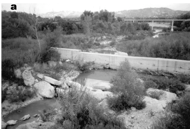
Fig. 3. Evidenze del disequilibrio dell'alveo del fiume Fino, nei pressi della confluenza con il Saline e a circa 9 km dalla foce: sottoescavazione di una briglia (a) e di un plinto (b).
