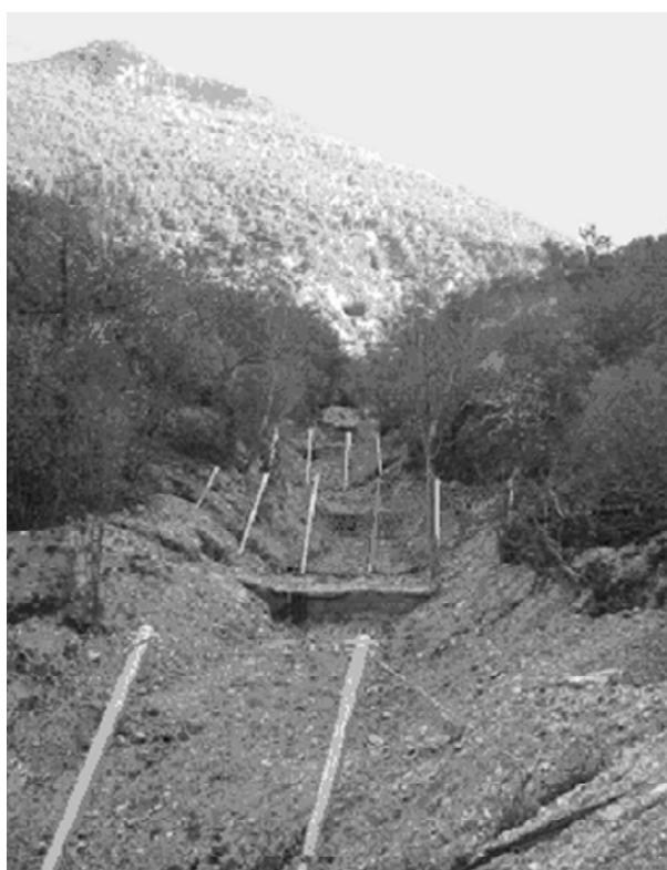
Fig. 12 - Briglie selettive in acciaio installate poche settimane dopo gli eventi di colata detritica per proteggere la strada dai sedimenti.
