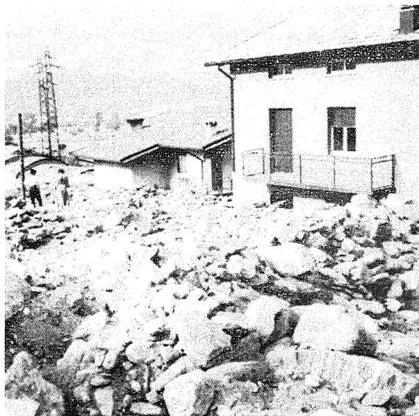
Fig. 6 - Alluvionamento con sedimenti molto grossolani in un centro abitato posto su conoide attivo per processi di colata detritica torrentizia. Fusine (Sondrio), conoide del T. Madrasco, luglio 1987.
