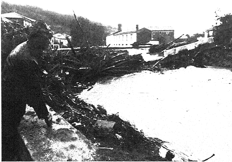
Fig. 7 - L'alluvione del 23/9/92 ha travolto il ponte sul T. Quiliano nel Savonese. The flood of 23/9/92 destroyed the bridge on the Quiliano River in the Savona area.
